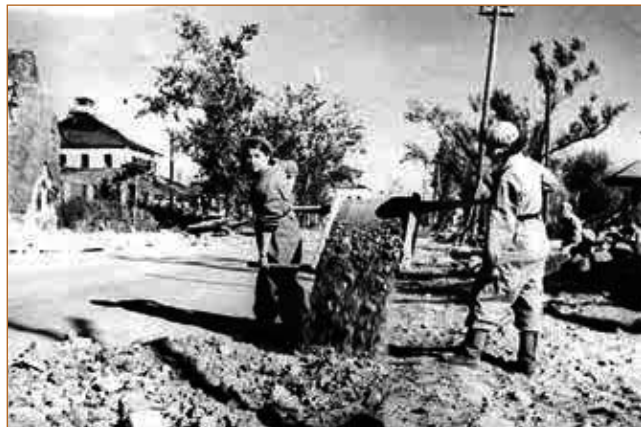
Бойцы 212-й роты МПВО г. Колпино ремонтируют «перешеек смерти». 1942 год
