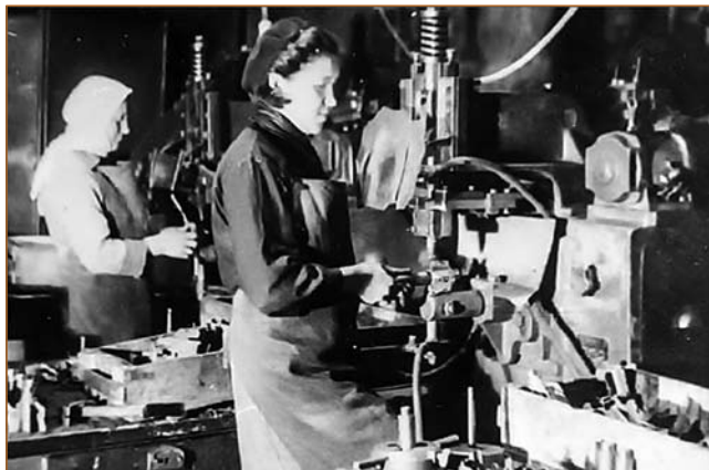
Сварка стабилизаторов 82-мм мин, 1943 год
