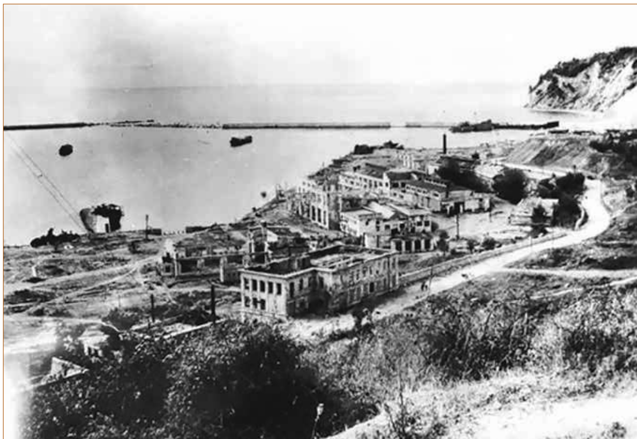
Разрушения в прибрежных районах Туапсе
