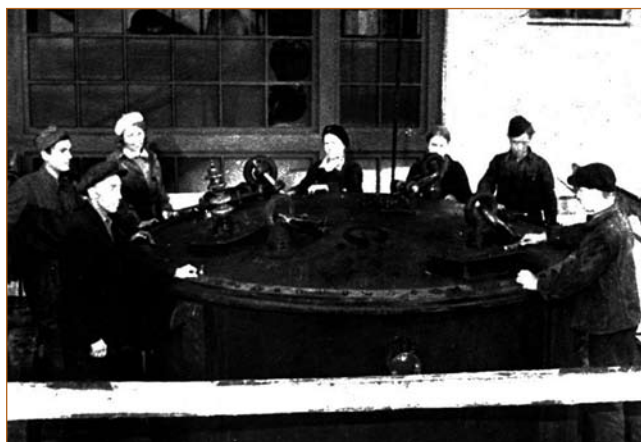
Восстановление Волховской ГЭС после бомбёжки. 1943 год
