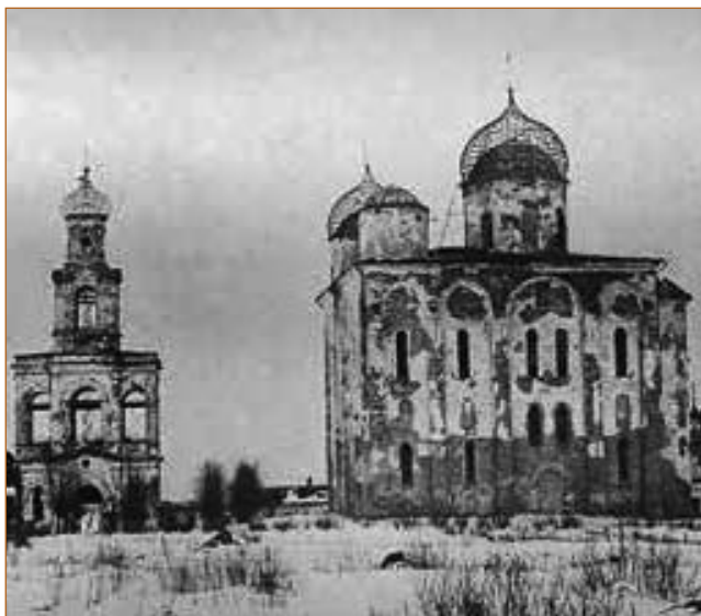
Юрьев монастырь, разрушенный оккупантами. Зима 1944 года
