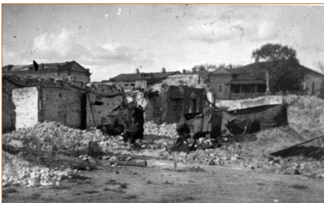
Разрушенные здания исторической части города. 1943 г.
