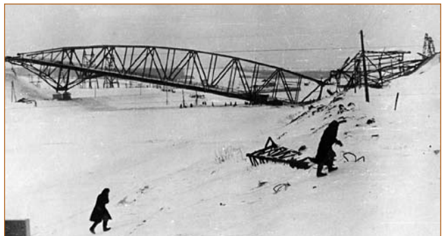
Разрушенный мост через канал в Яхроме. Из архива МЗДК
