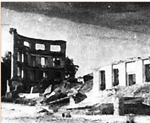
Разрушенное здание гостиницы «Северная». 1944 год. Фото Г.А. Анкудинова
