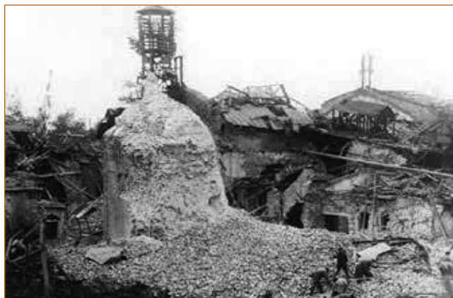
Разрушенная заводская электростанция. 1941 год
