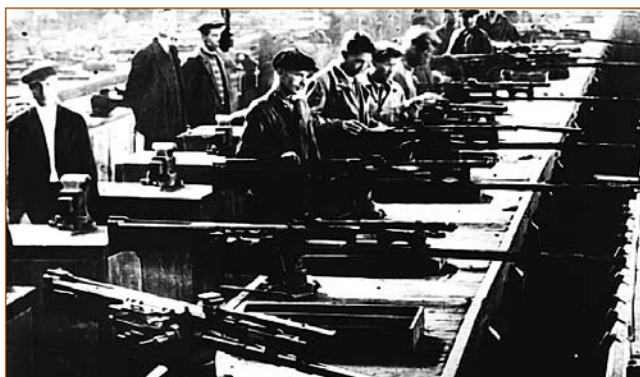
Сборка авиационной пушки ВЯ-23 на одном из заводов
